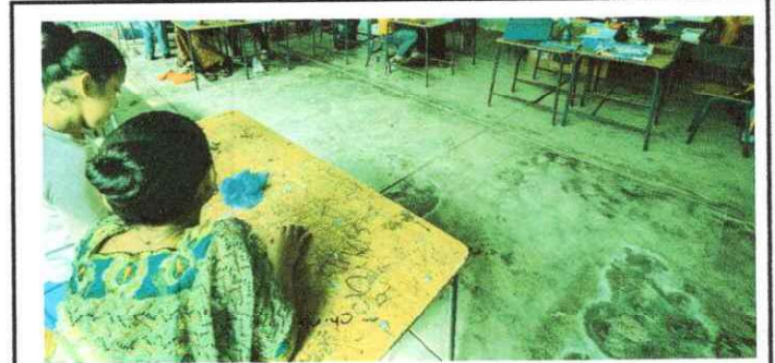
Foto 6: El piso deteriorado, presenta agujeros y algunas grietas por la humedad provocada de agua que ingresa del techo.
