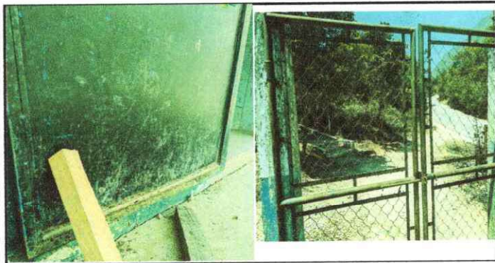
Foto 5: Las puertas de metal del establecimiento deterioradas, como también la puerta de ingreso al mismo.
